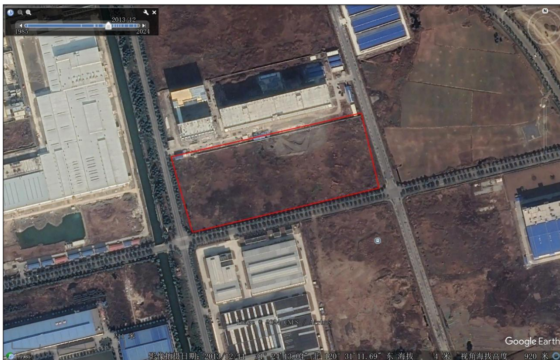
2013年12月，本地块为空地，南侧、西侧、北侧为厂房，东侧为空地
