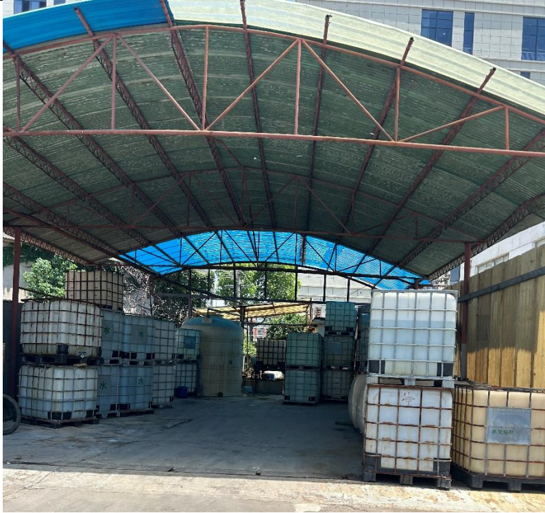
污水输送管道照片
