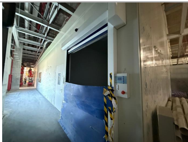
项目拟建场址西侧（规划为 1 楼车间生产线）
