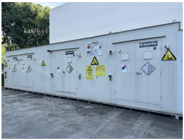
危废仓库外危废标志牌
