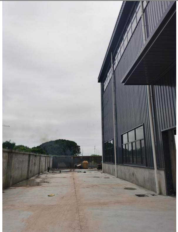
本项目探伤房拟建址西侧厂内道路
